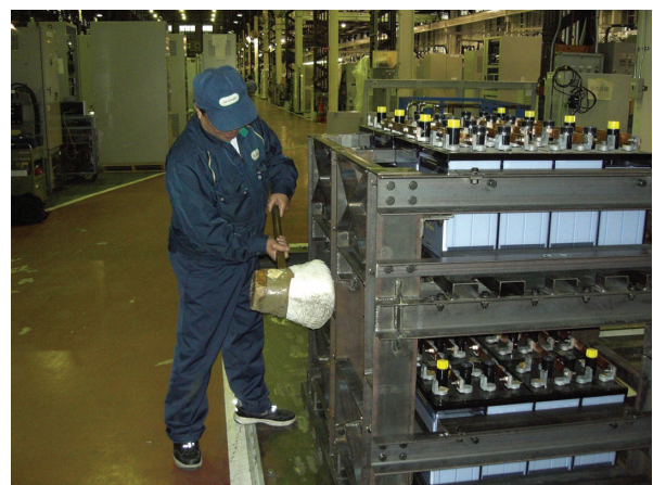
図6 蓄電池設備の打振試験風景
