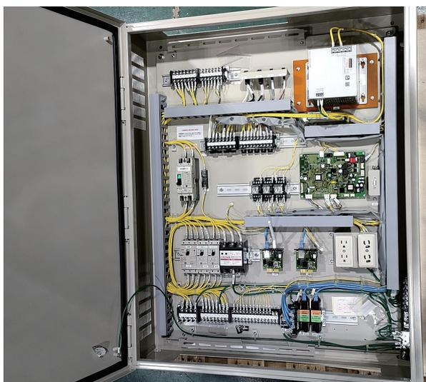
図3 制御盤外観イメージ
