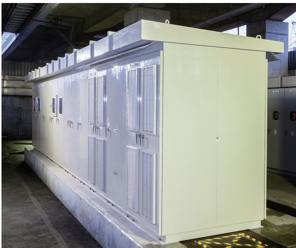
3. 回生吸収用リチウムイオン電池「LIM25H-8」
