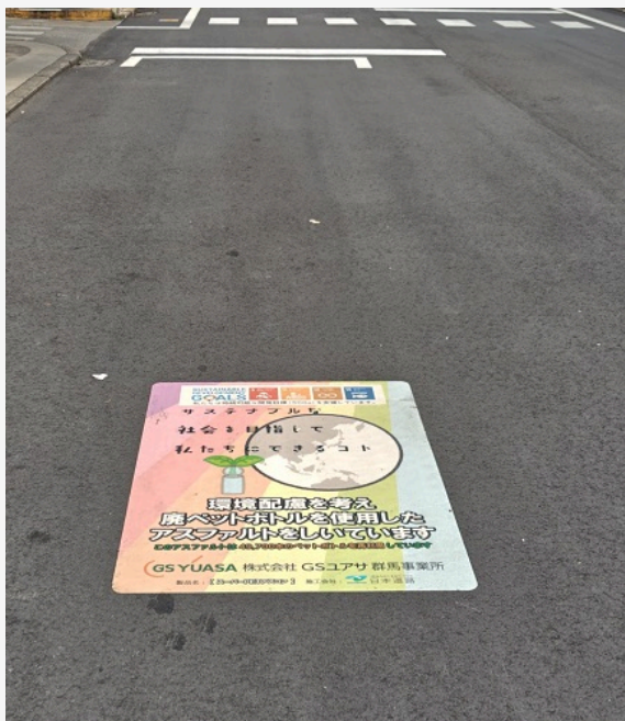
環境に配慮した敷地内道路の舗装（群馬事業所）
