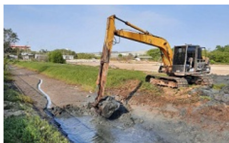
河川の浚渫工事 (SGS)
