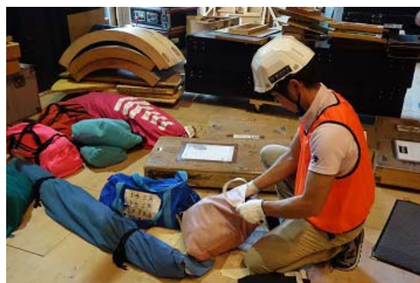
解体作業の様子
