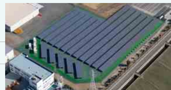
群馬太陽光発電所
