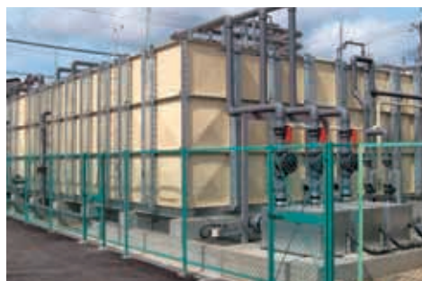
■排水貯水タンク Drainage water storage tank
