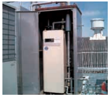
▲分散化小型ボイラー Decentralized small boiler
