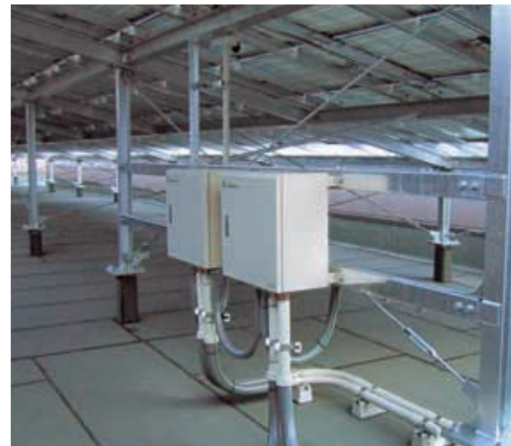
▲ ラインバックαプラス (10kW×23台設置) Line Back α plus (installation of 10kW×23)
