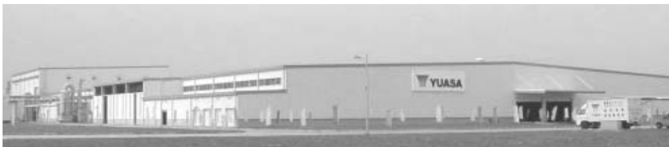
湯浅蓄電池(順徳)有限公司 全景
