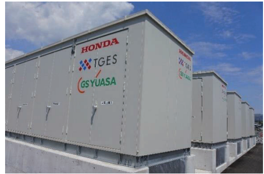
Honda 熊本製作所に設置されたりチウムイオン蓄電池設備（コンテナシステム）
