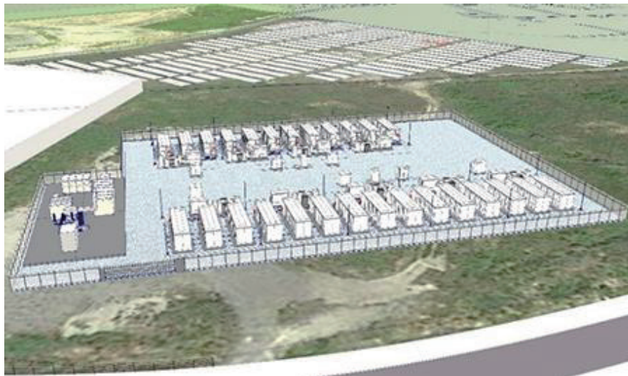
角子原パワーストレージステーション完成イメージ （敷地内に並んでいる白いコンテナが蓄電池設備）
