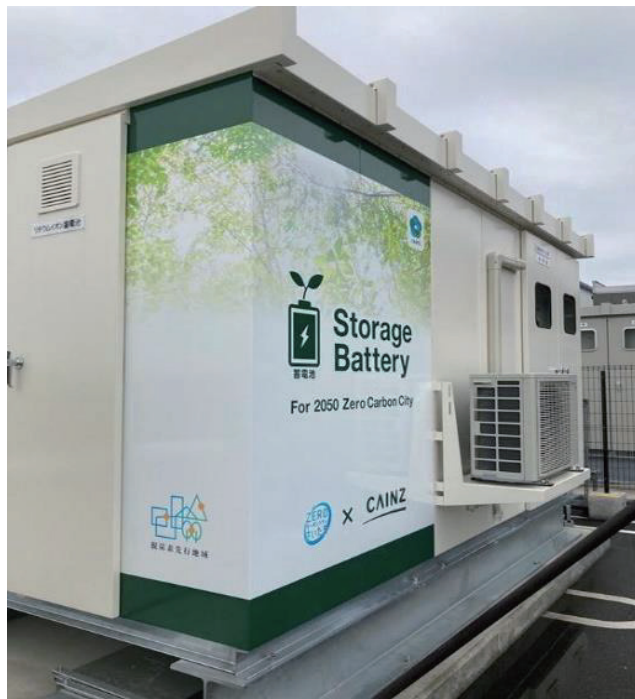
納入したリチウムイオン蓄電池設備
